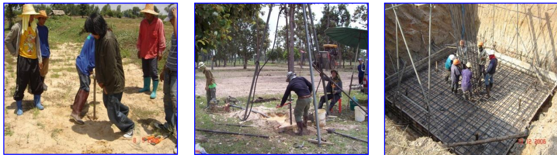
ขั้นตอนที่ 2 - 4 งานเจาะสำรวจชั้นดิน งานตัดต้นไม้ และงานก่อสร้างฐานราก
